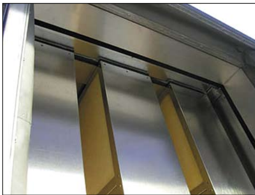
Рис. 3.32а. Пластинчатые шумоглушители
