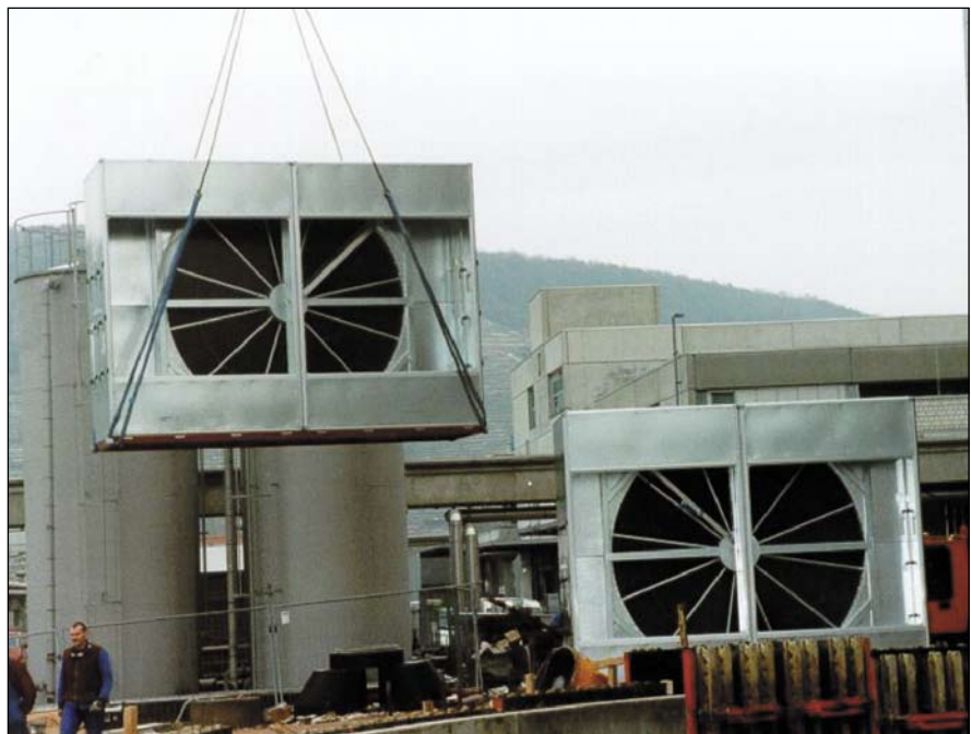
Рис. 3.37. Вращающийся регенеративный теплоутилизатор
